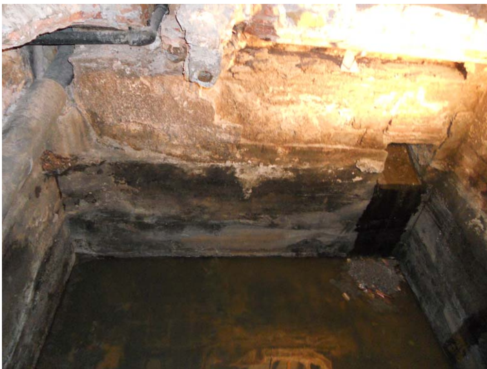
071/13-79. Fossa sèptica localitzada, quan es va extreure la runa.
