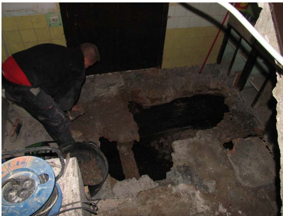
071/13-37. Localització de la fossa.
